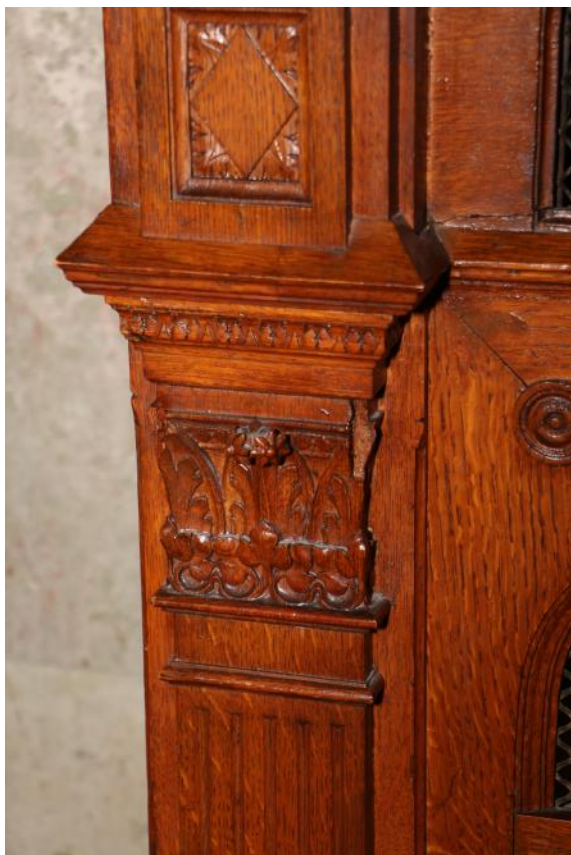
Radiátorburkolat – voluta hiánya
