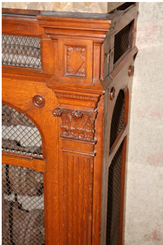
Radiátorburkolat – voluta hiánya
